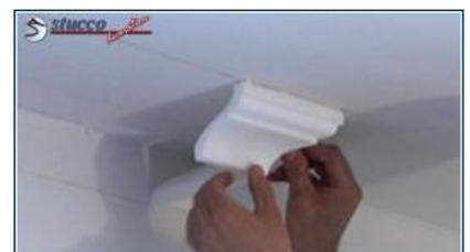
**4. Kleben der Stuckleisten aus Styropor**
