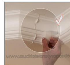
Wie auf dem Montagevideo zu sehen ist, verwenden wir an den unteren Stosskanten zusätzlich ein Glasfaserband. Dadurch wird die Stabilität der Konstruktion gesichert.
